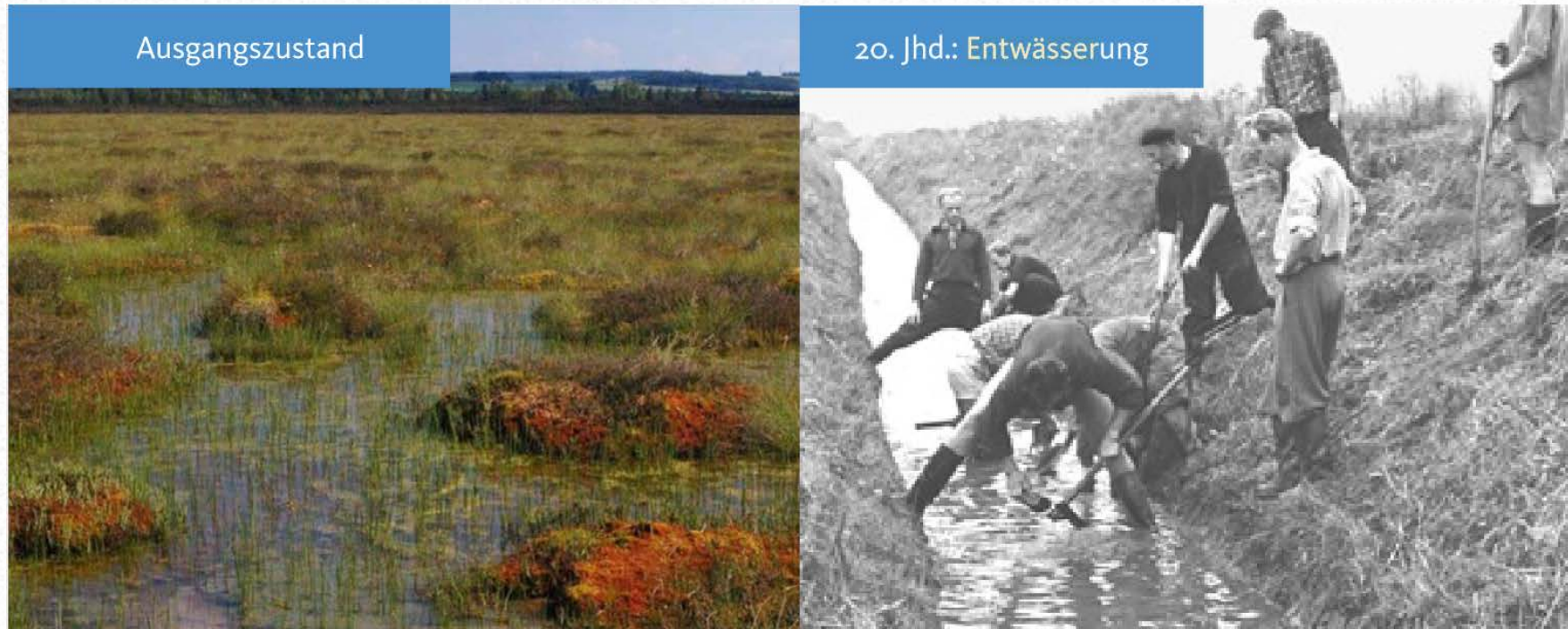
Abb. 6: Entwässerungsarbeiten (aus: Joosten et al. 2019)
